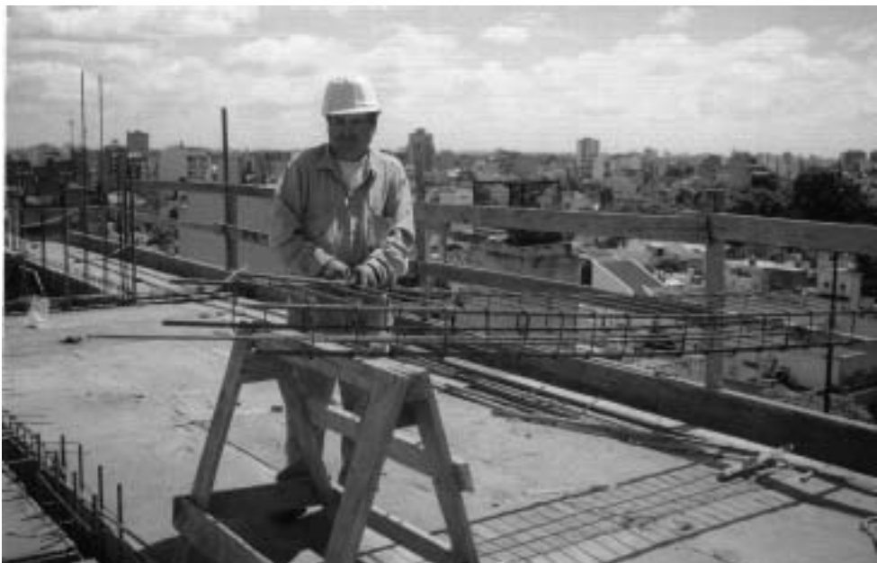
Capataz de los armadores armando una columna.
