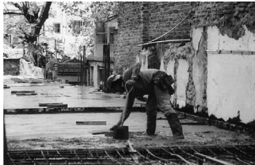
Carpintero alisando el hormigón con un fratacho.
