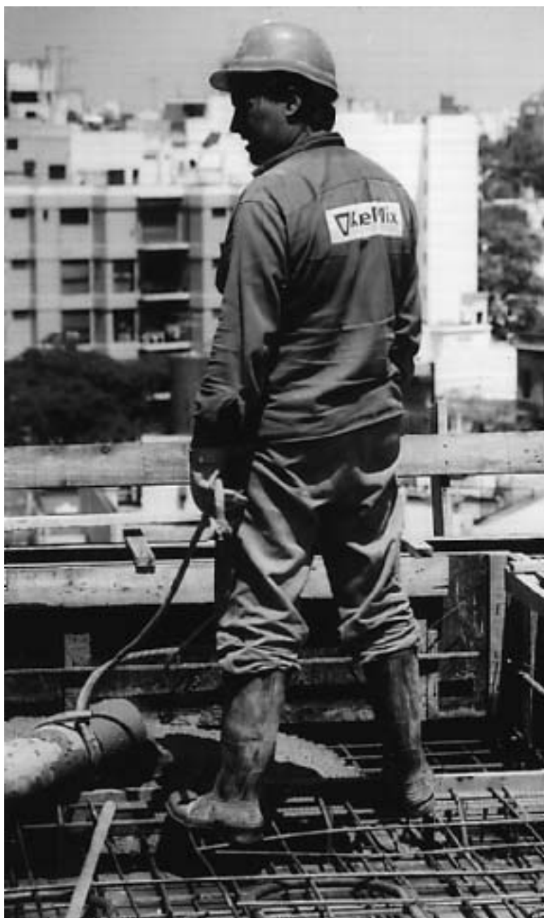
Trabajador de la empresa proveedora de hormigón.
