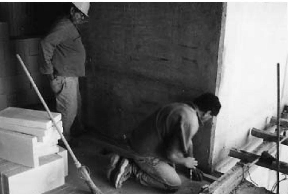
Albañiles realizando el replanteo.
