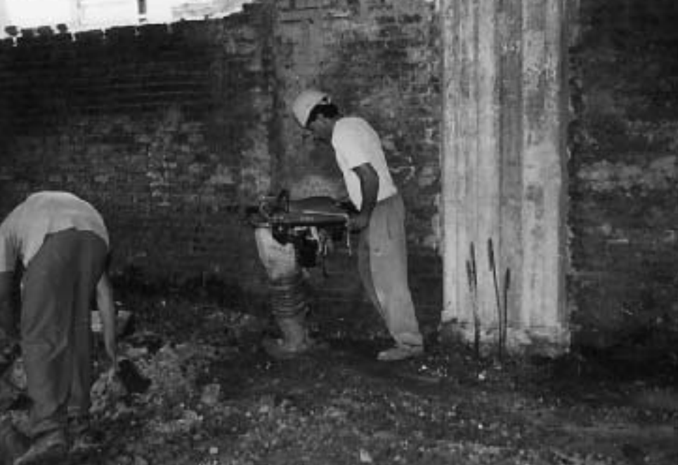
Ayudante de la albañilería trabajando con el pisón.
