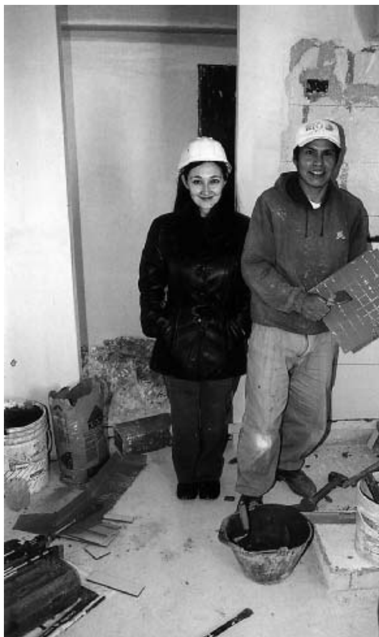
El contratista de la colocación y la investigadora en la obra.
